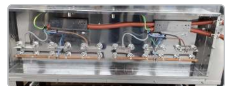
Anschlusskasten vom 34.G HD: „Heavy-duty“ Version mit serienmäßiger Verdrahtung mit Kupferstromschienen
